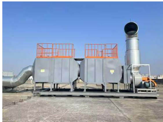
▲ 改善後 (風機檢修、增加防震軟管及消音管)
